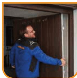
Demontaż i ekologiczna utylizacja
